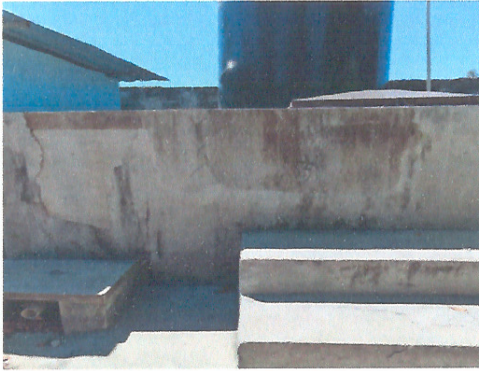
Foto 3: Mejoramiento de depósito de agua
