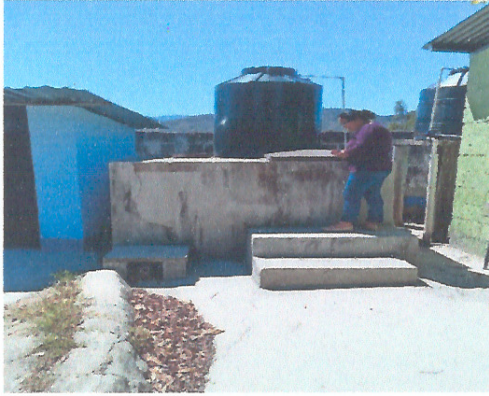
Foto 1: Mejoramiento de depósito de agua
