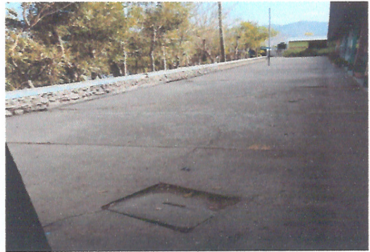
Foto 4: Mantenimiento losa de patio
