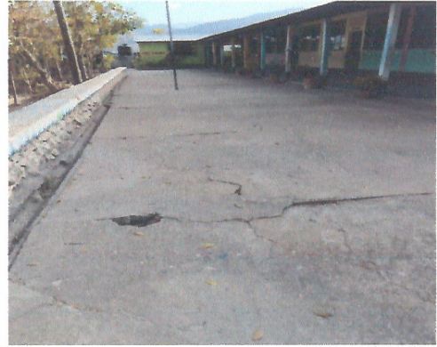
Foto 2: Mejoramiento de losa de patio
